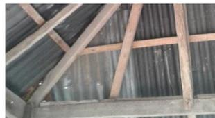
Bapak Gusti Made Kariasa membuat konstruksi *Lambang* dengan menggantikan kayu yang asli menggunakan kayu yang baru yaitu kayu kelapa (*seh-seh*). Konstruksi *lambang* di tempatkan dan disatukan pada ujung-ujung tiang atas. Kayu *lambang* berfungsi sebagai tempat tumpuan kontruksi *iga-iga*. Jumlah kayu *lambang* yaitu 4 biji yang mengelilingi tiap sisi panjang dan lebar bangunan.
